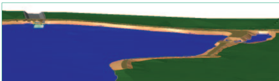
Вид на плотину со стороны верхнего бьефа
